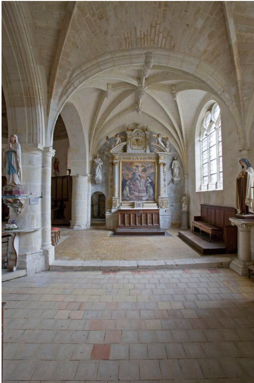
Travée 5 du bas-côté sud
