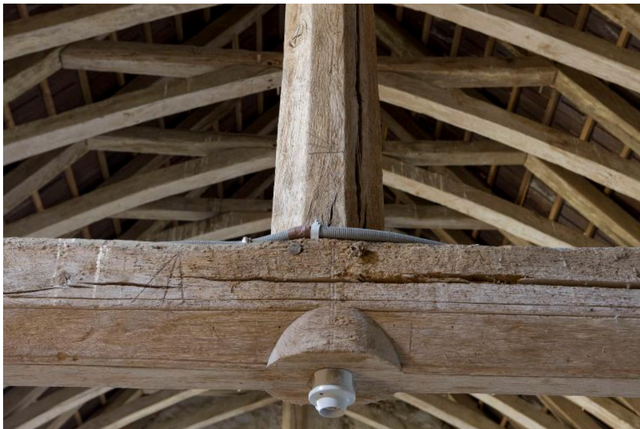
Chapelle, charpente : détail.
