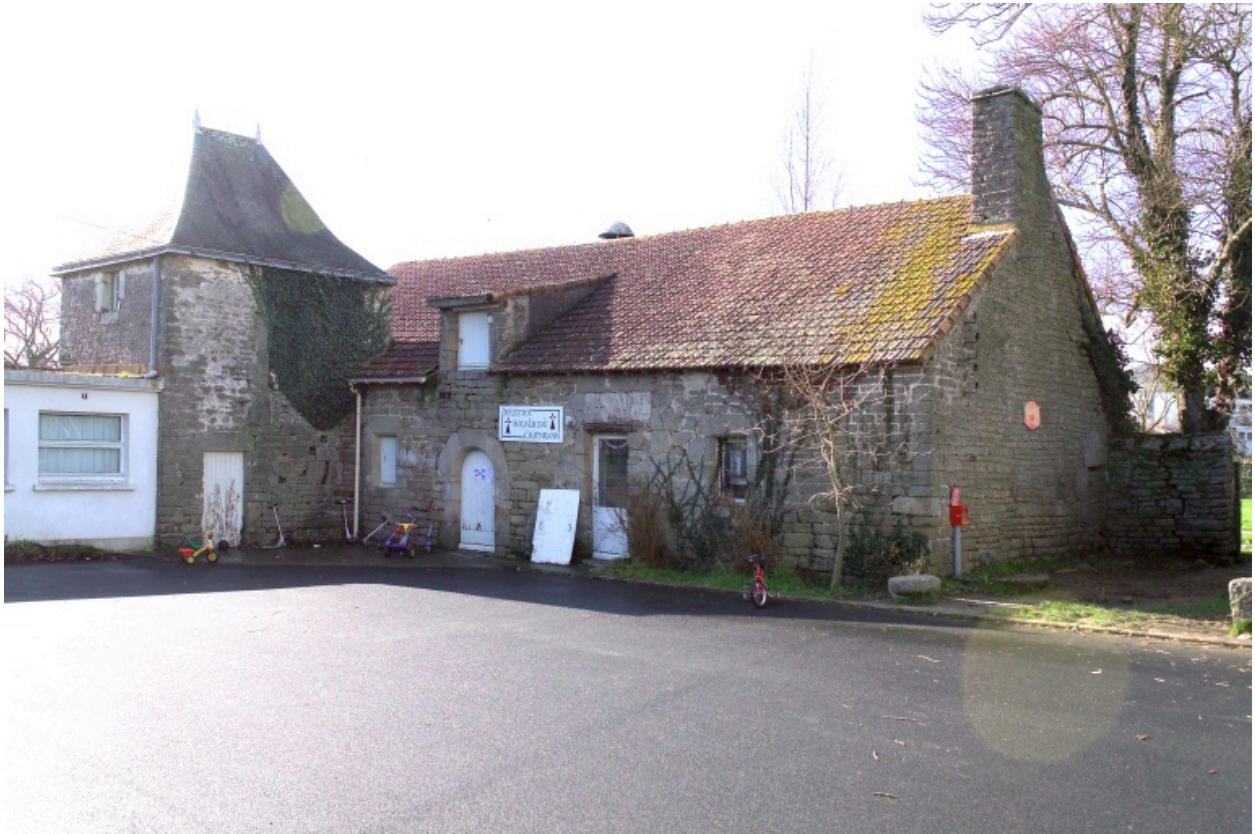
Bâtiment ouest et tour quadrangulaire. Vue depuis l'est.
