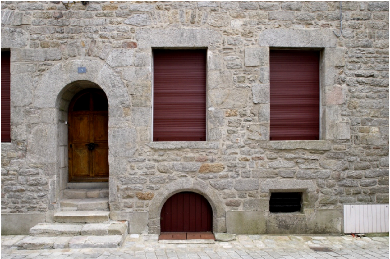
Détail des ouvertures de la façade sur rue.
