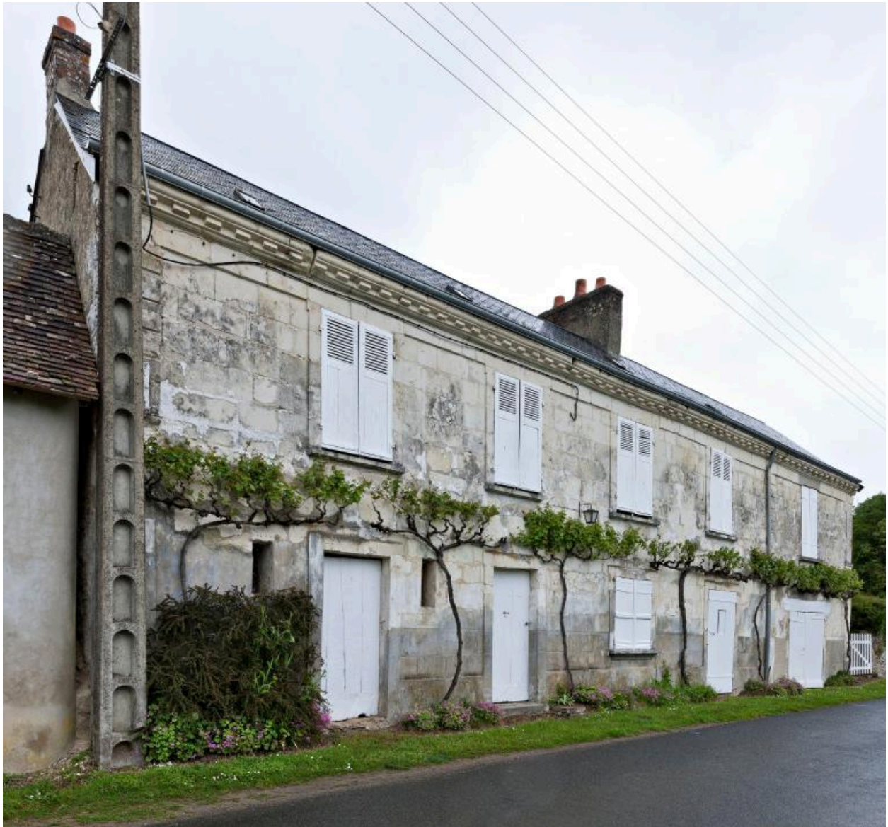
Maison : façade ouest à l'aplomb de la route.
