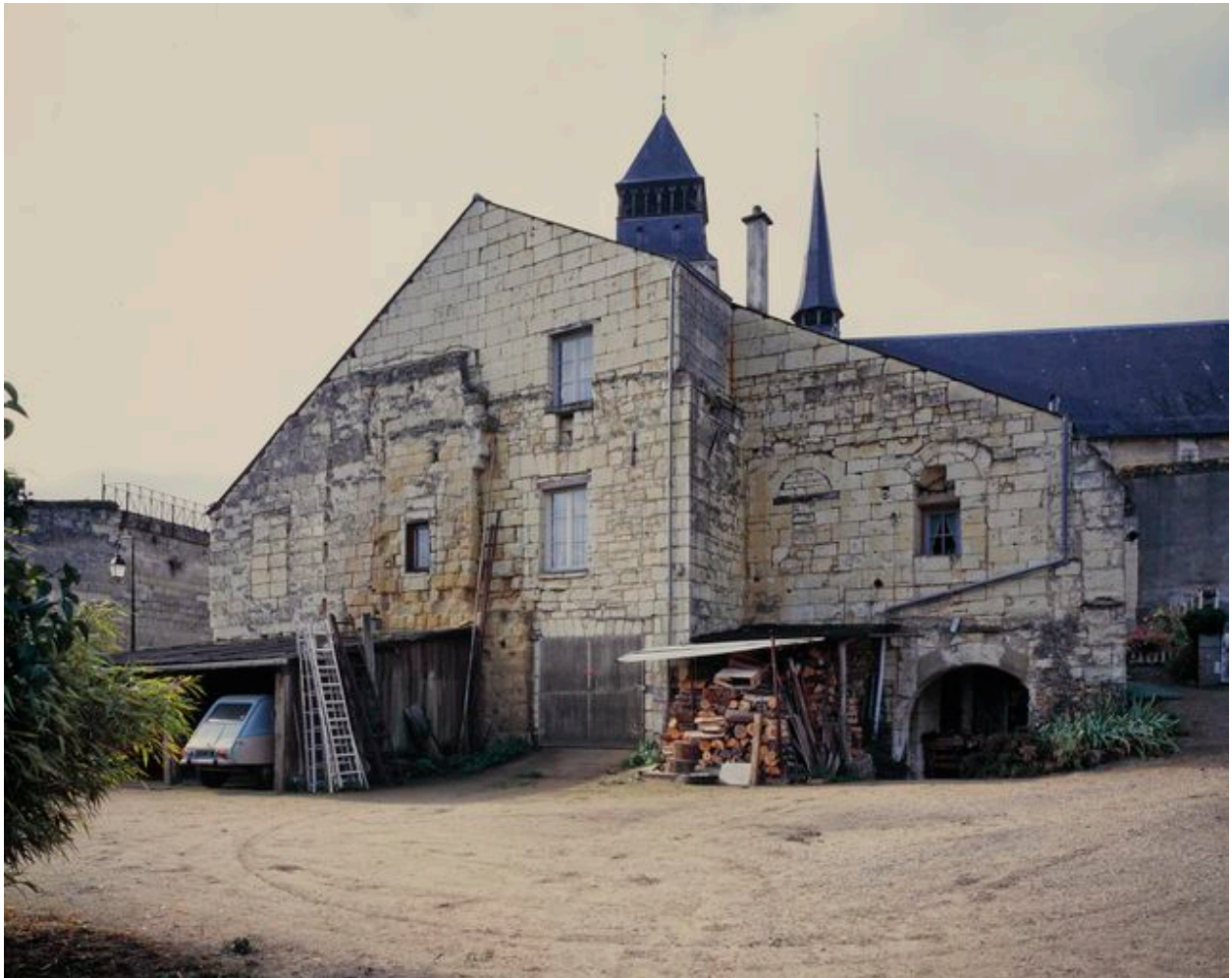
Vue générale de la façade nord, très remaniée.
