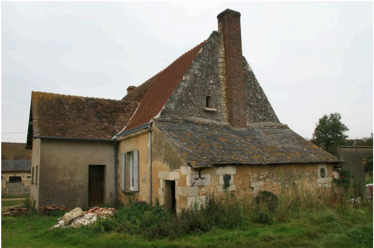
Vue de volume de la maison : façade postérieure.
