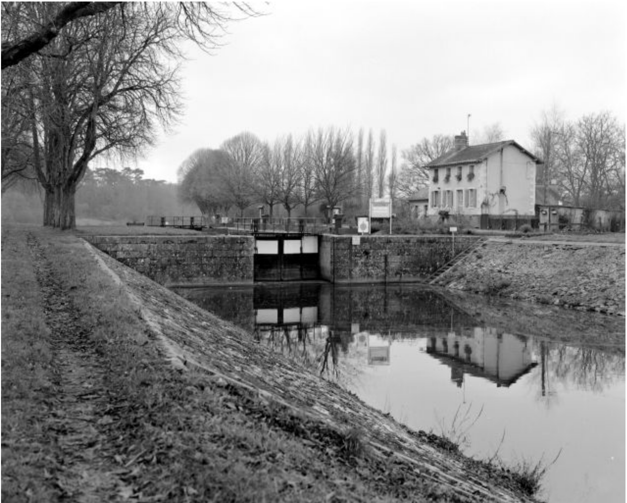
L'écluse et la maison éclésièr vus depuis la digue en amont.
