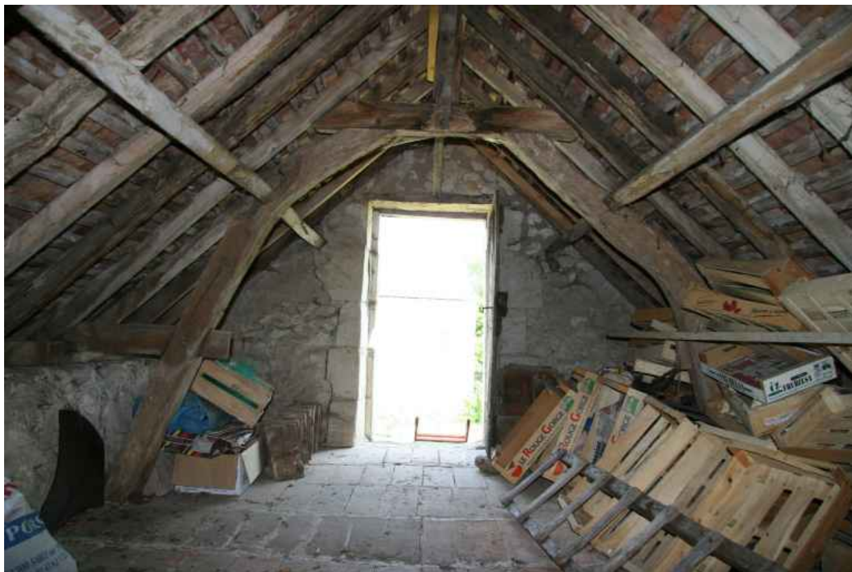
Maison 4, dépendances : charpente de comble à surcroît.
