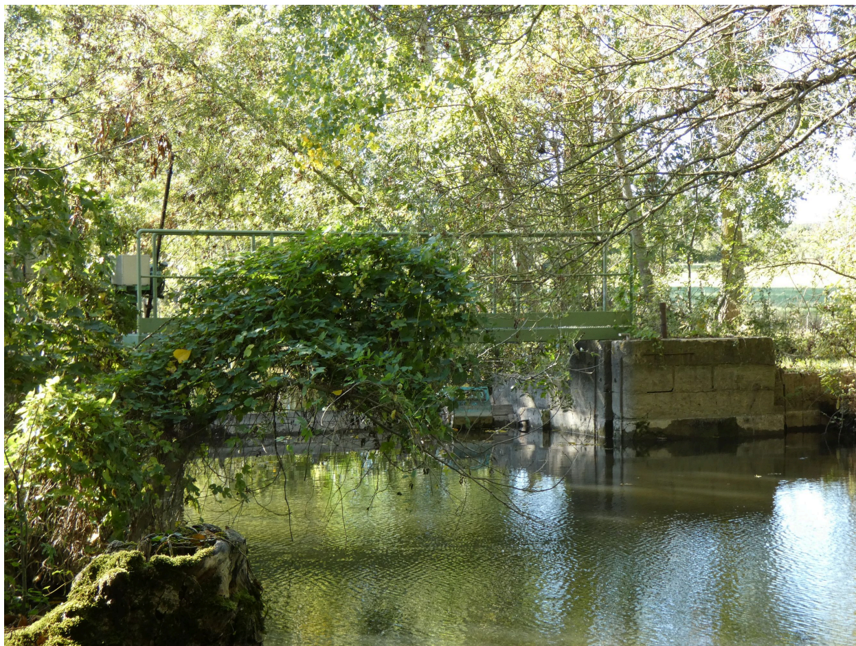
Le barrage vu depuis l'est, en amont.
