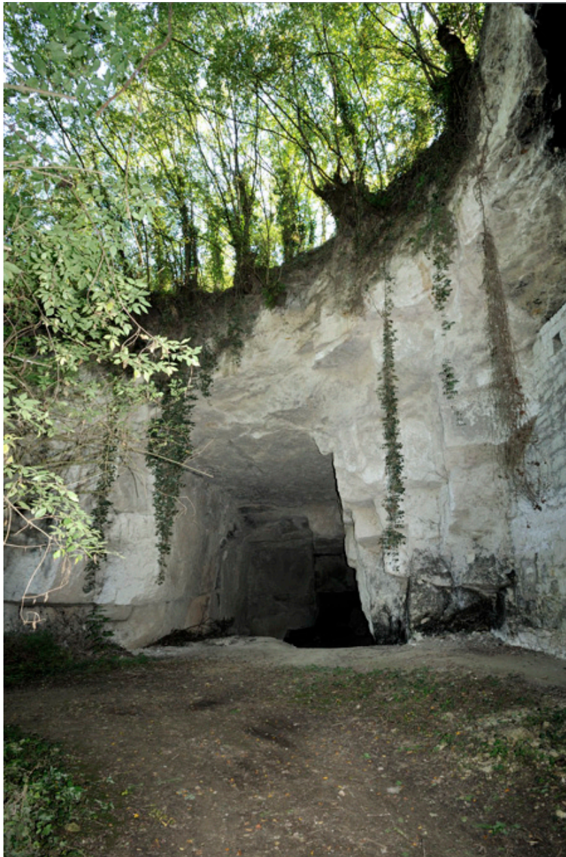
Site principal (11-16, ruelle des Perreyeurs). Fontis ouest. Entrée d'une galerie.
