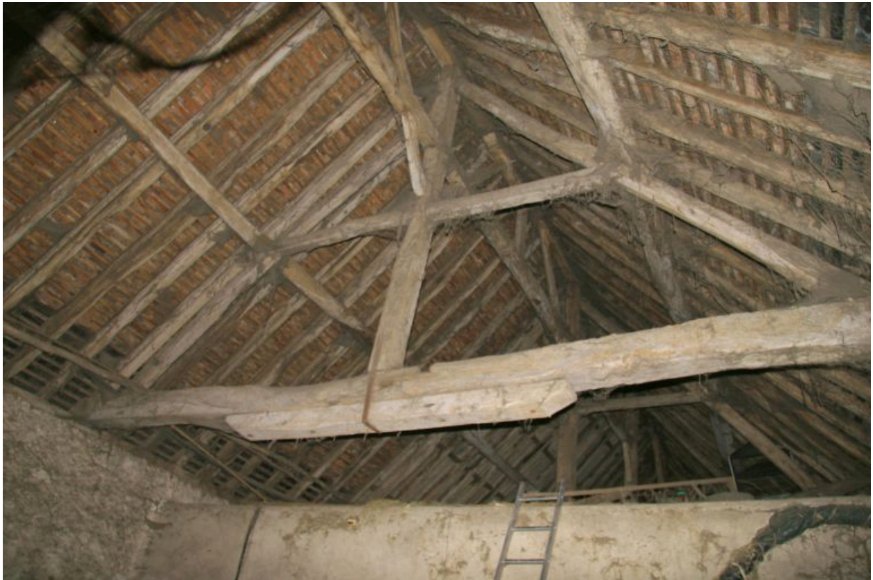
La grange-étable : charpente à pannes.
