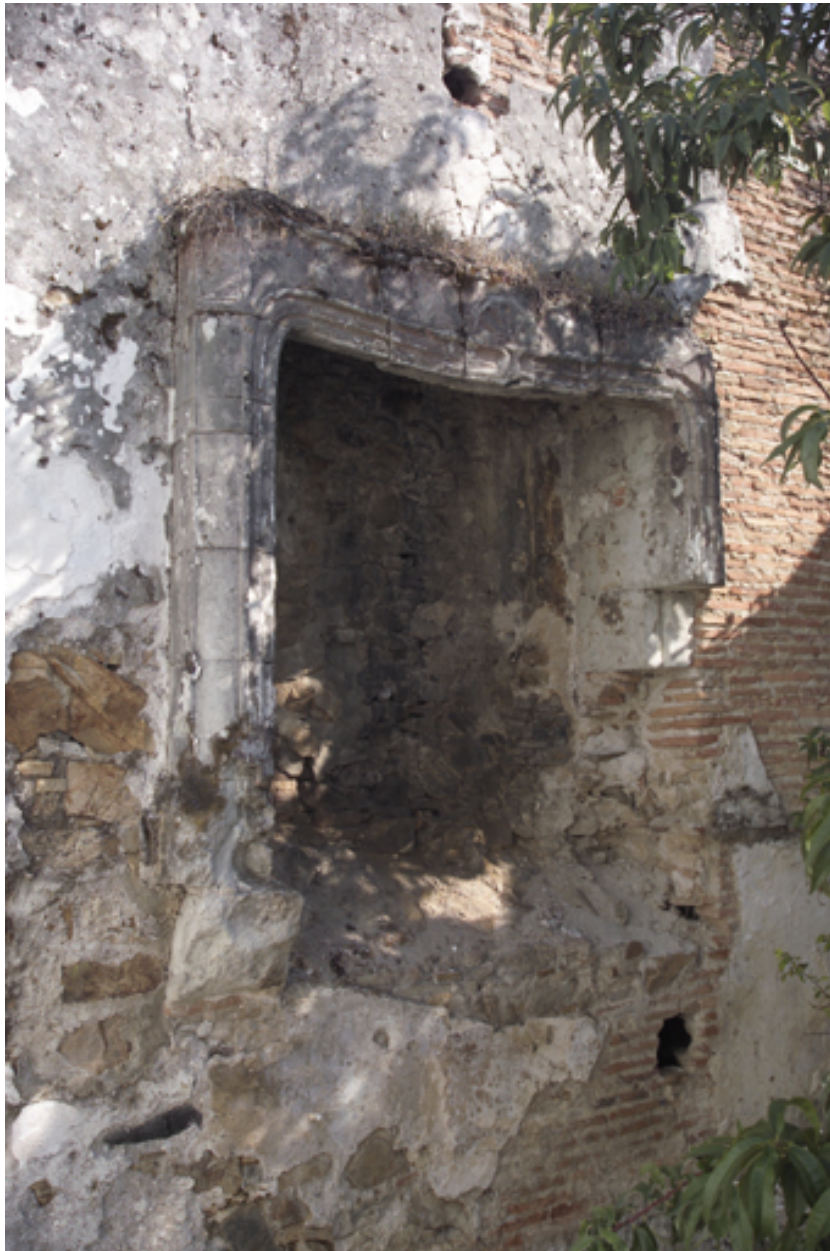
La cheminée subsistant à l'est de la cour après la démolition du corps secondaire de la maison n° 39 rue du Faisan.
