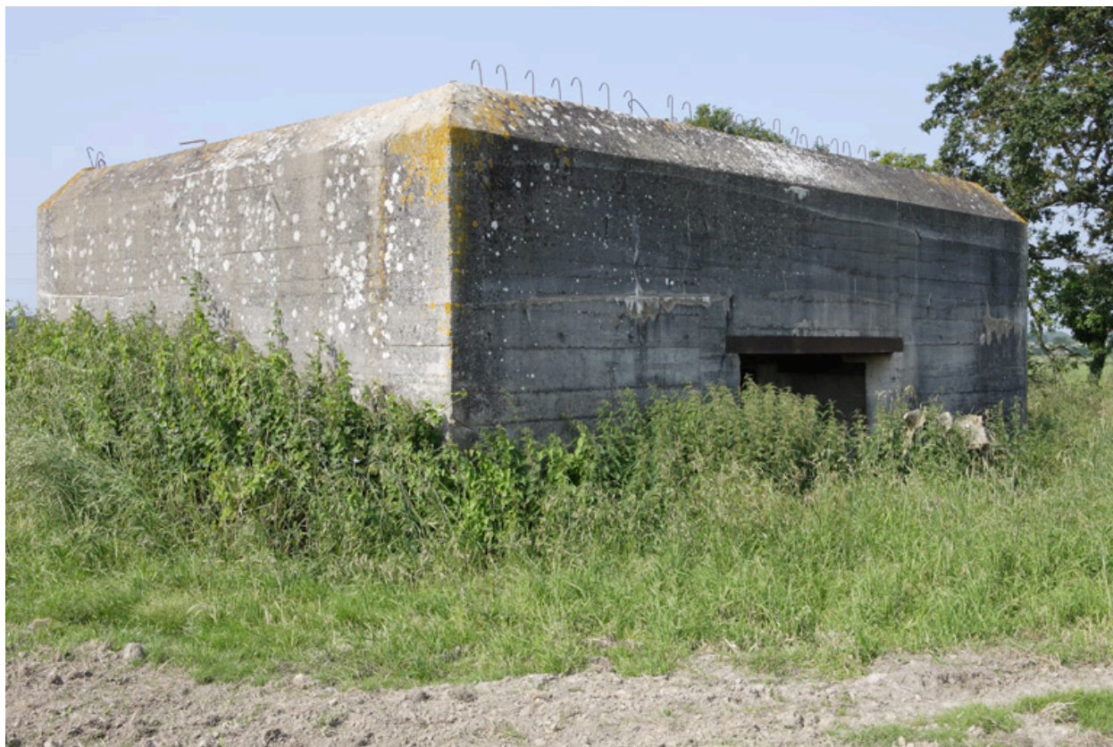
Vue de la casemate n° 2 (côté entrée).
