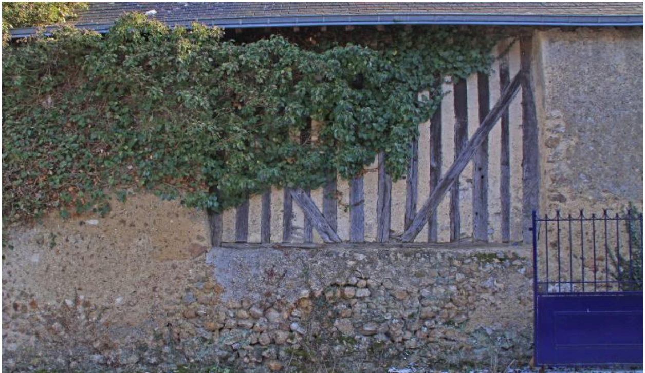
Grange : façade postérieure en pan de bois.
