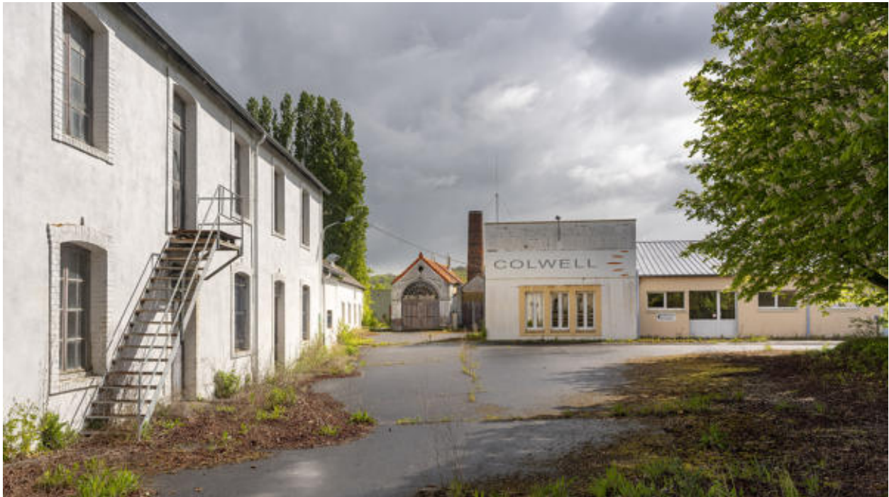
Vue d'ensemble de l'usine textile.
