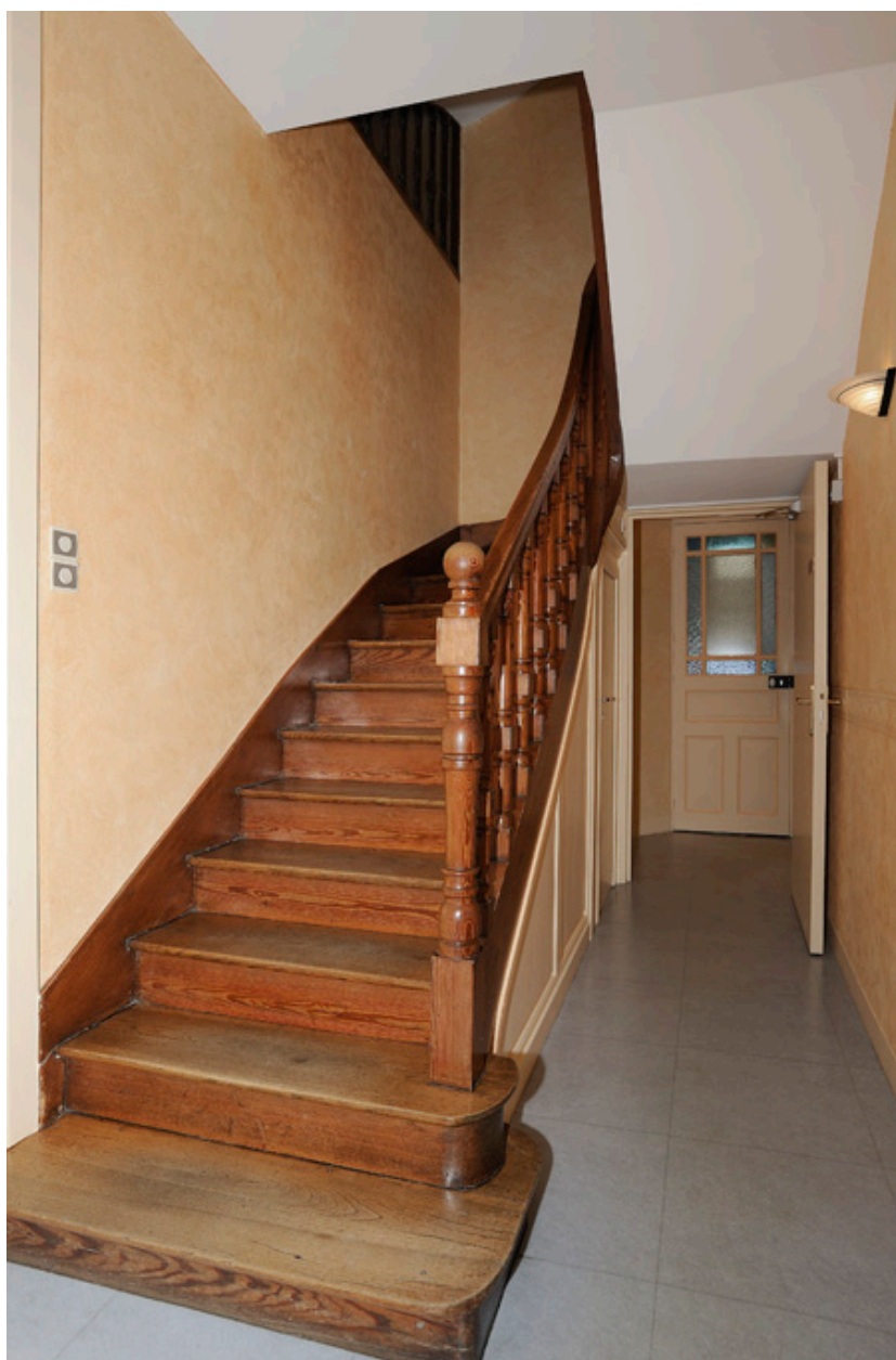
Escalier de distribution.
