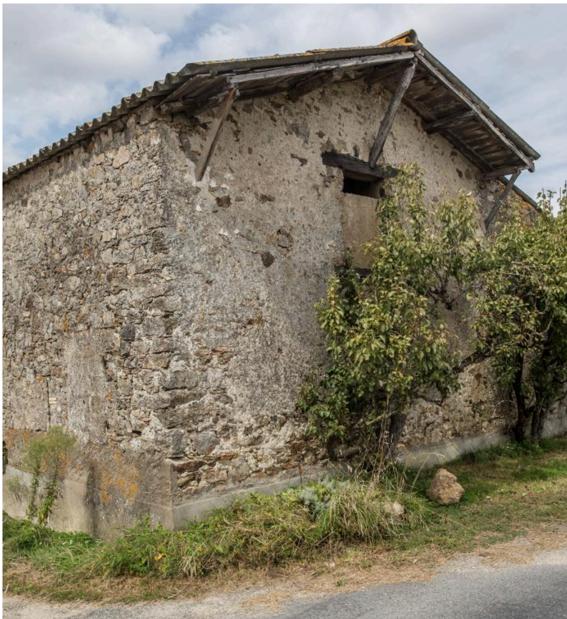
Mur pignon d'une grange avec débord de toit formant auvent. La Mauvillonnière, La Planche, cadastre 2018, 000 YA 01-185.
