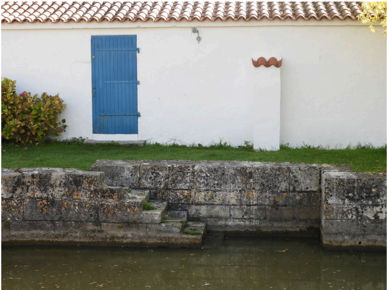
Quai et emmarchement sur la rive gauche de la bonde, au pied de l'ancienne maison de garde.
