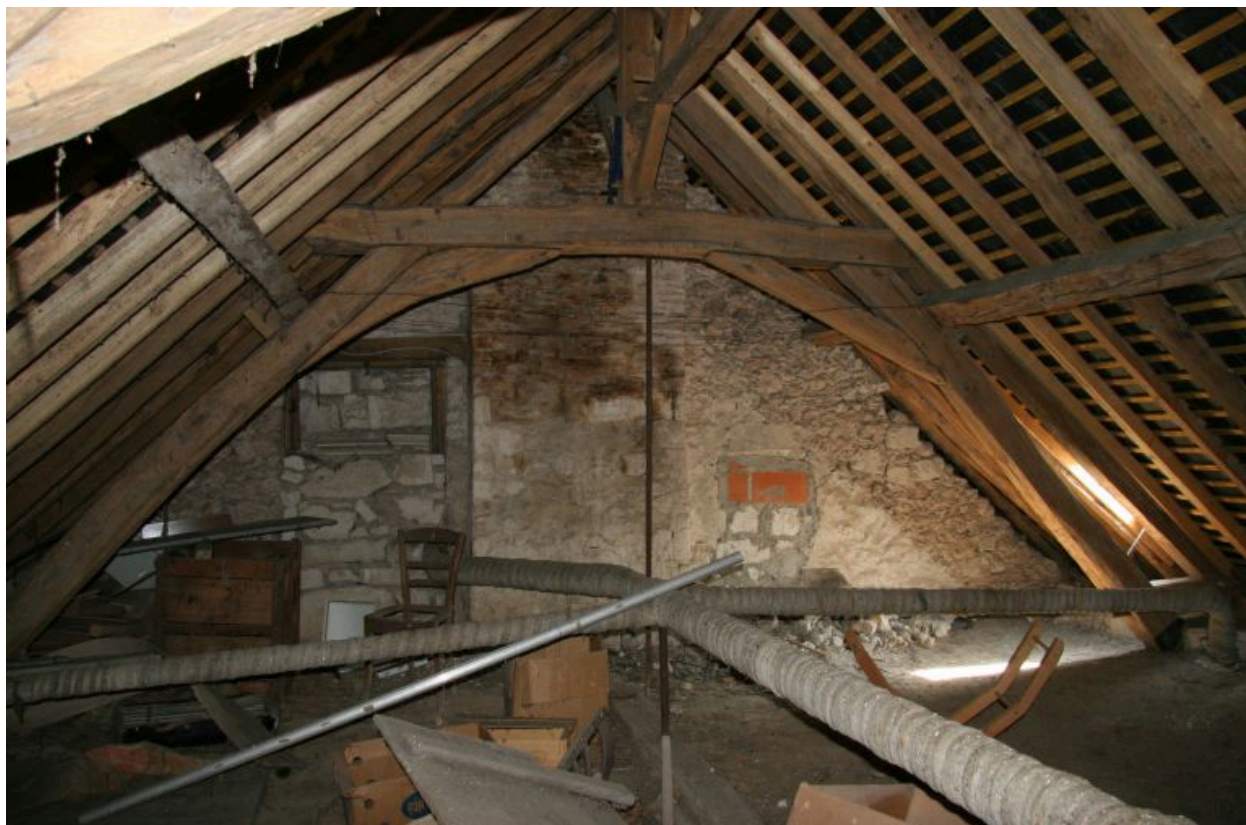
Charpente sur poteaux.
