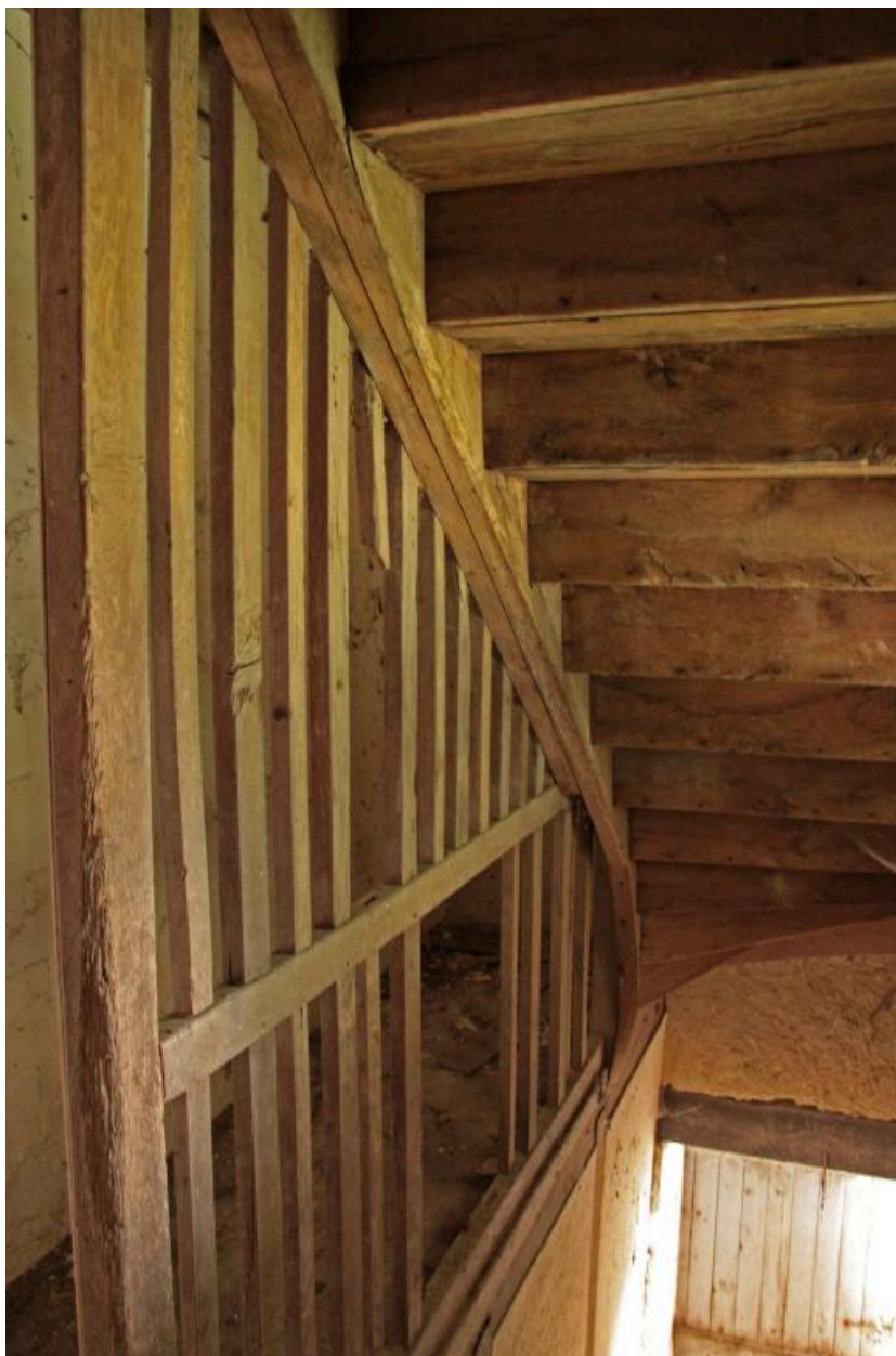
Vacherie, bâtiment d'habitation (au sud) : escalier.
