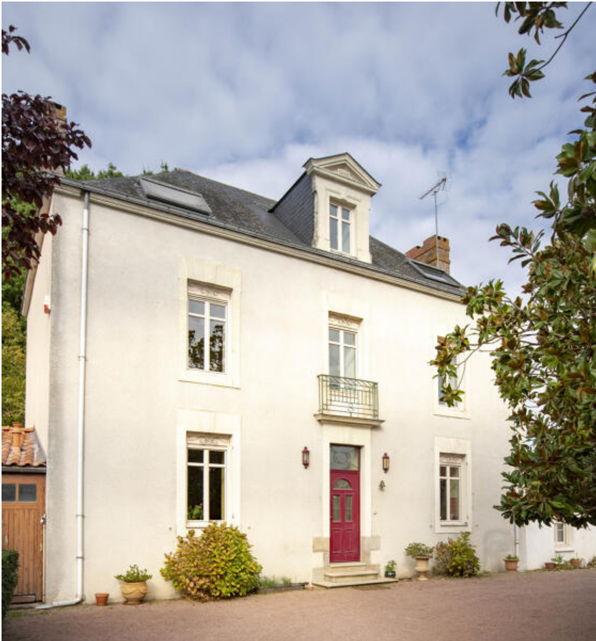
Maison de maître, depuis la cour.
