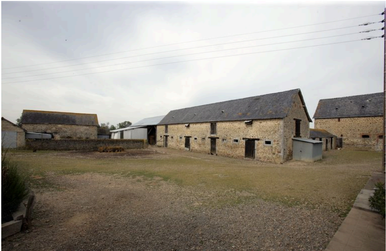
La remise, l'étable-grange et l'étable à chevaux.
