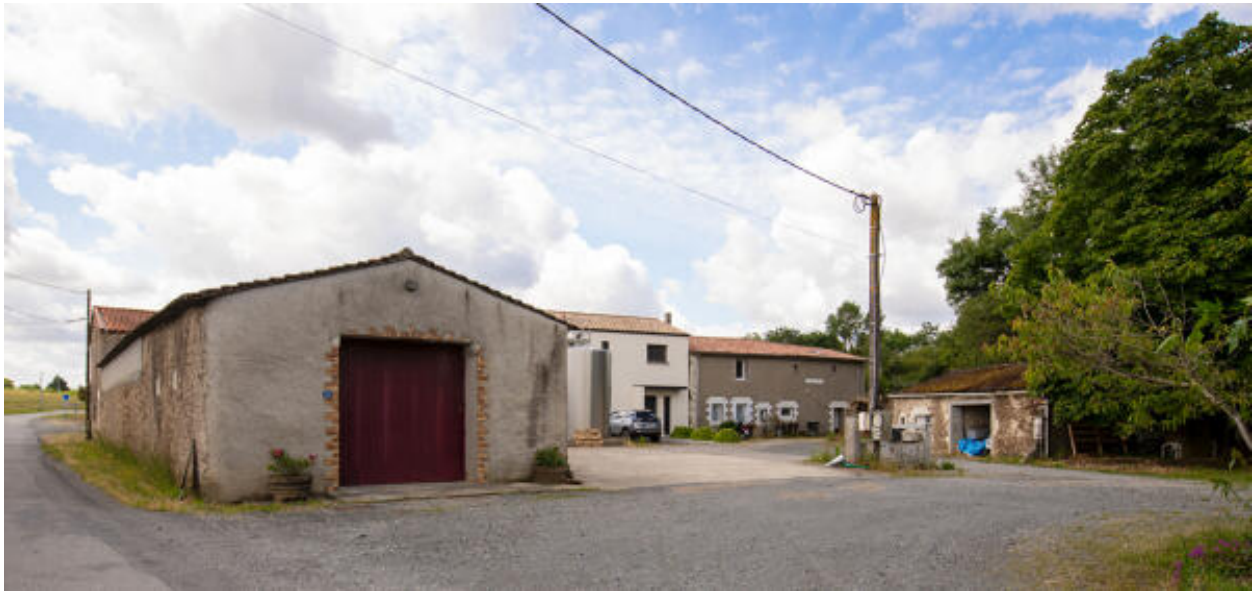
Vue générale du site, depuis la rue des Châteaux.
