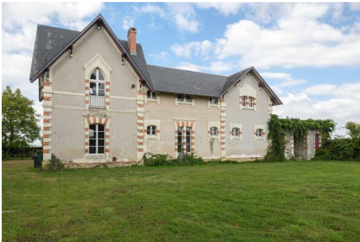
Vue d'ensemble des écuries depuis le sud.
