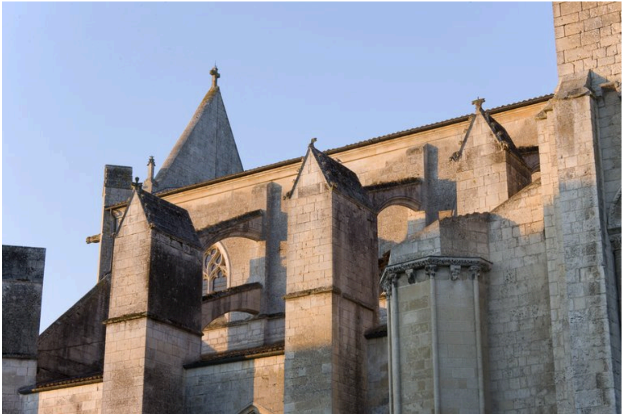
Façade nord du chœur : partie supérieure.
