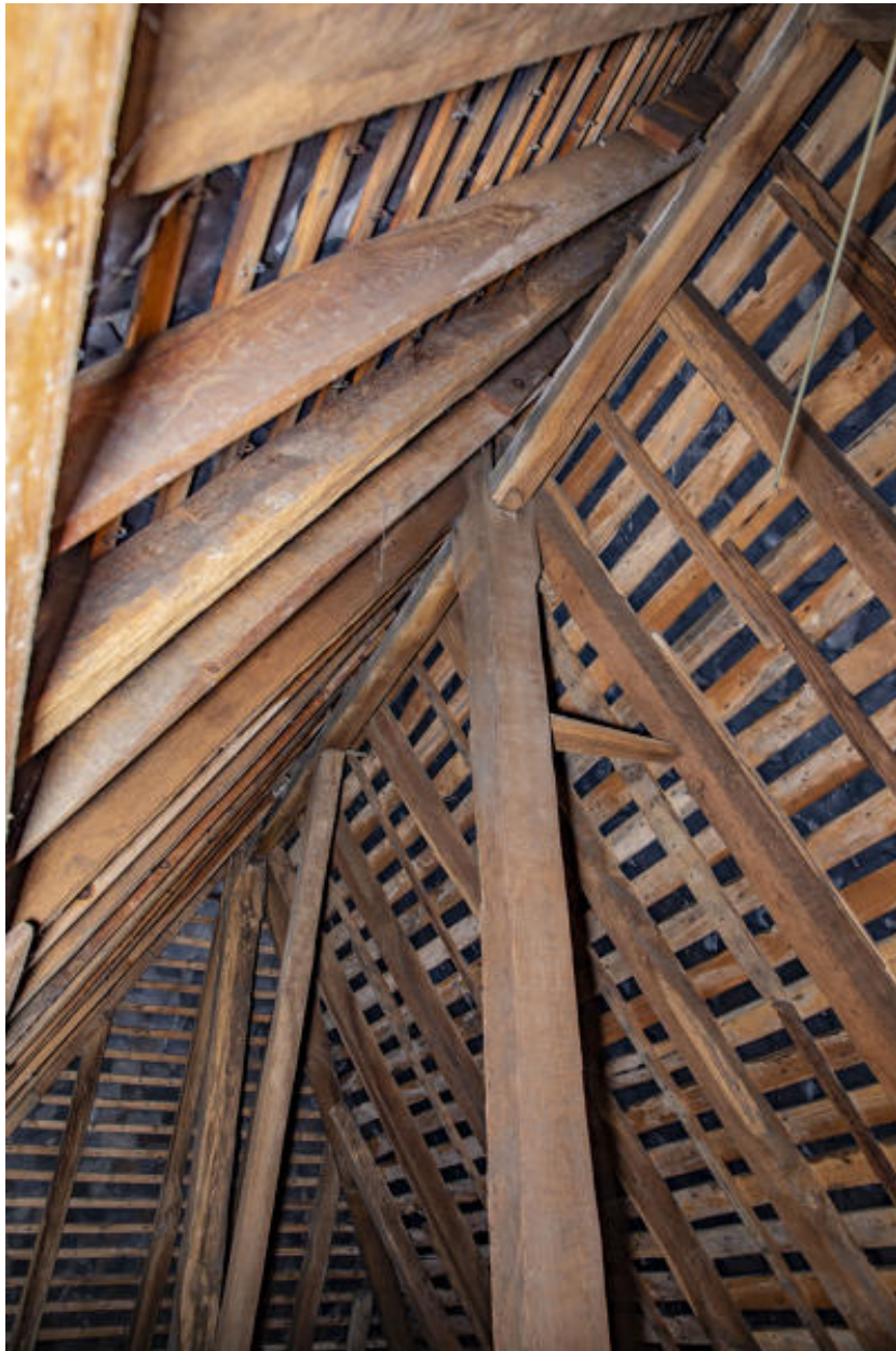
Vue de la partie supérieure de la charpente.
