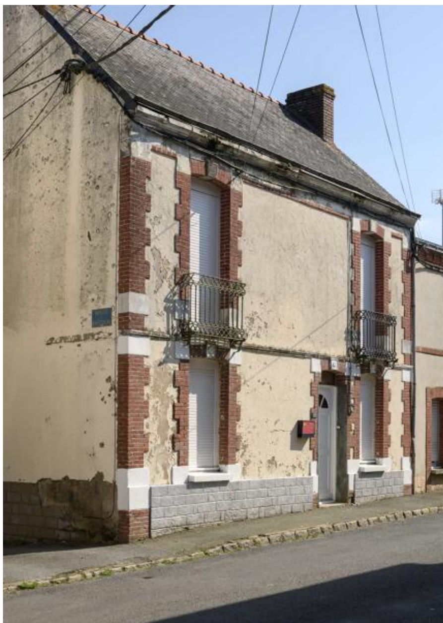
Beausse, 18 rue de la Mairie. Maison, 1er quart 20e siècle.
