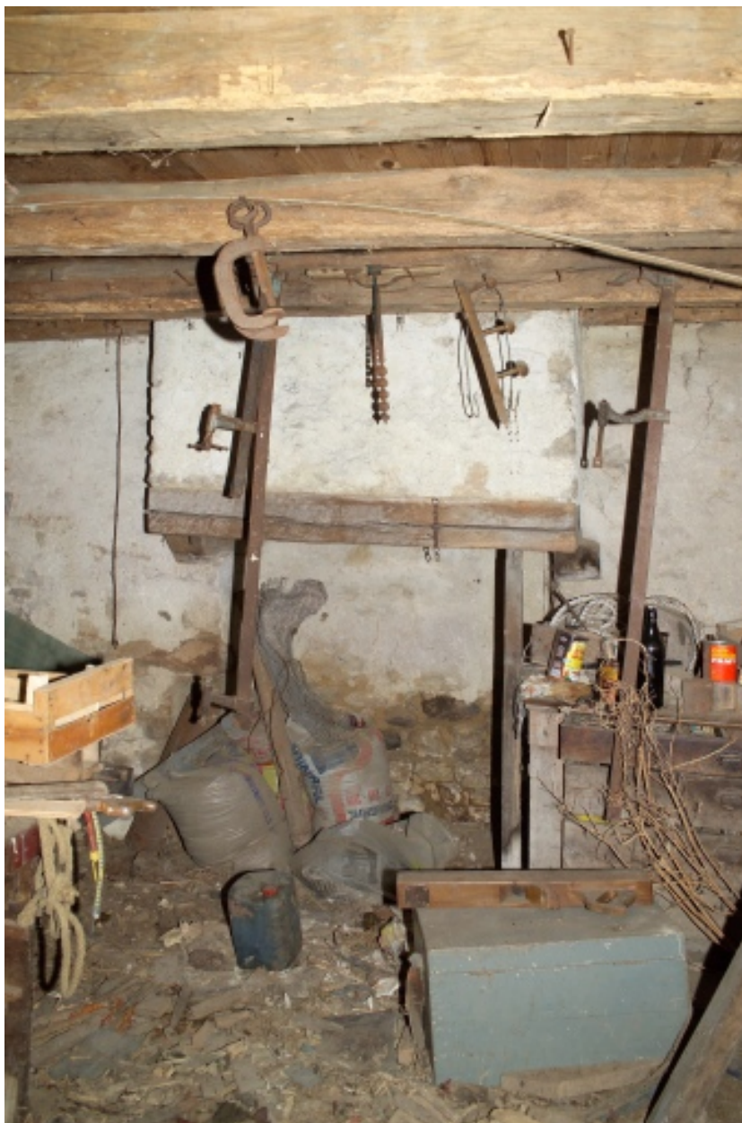
Dépendance, vue de la cheminée.
