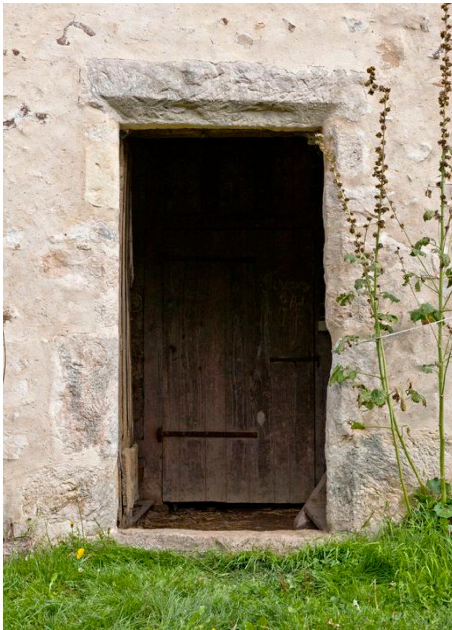
Porte gauche sur la cour du corps principal du logis.
