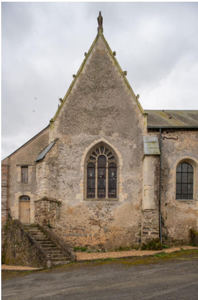
Le pignon du bras nord du transept.
