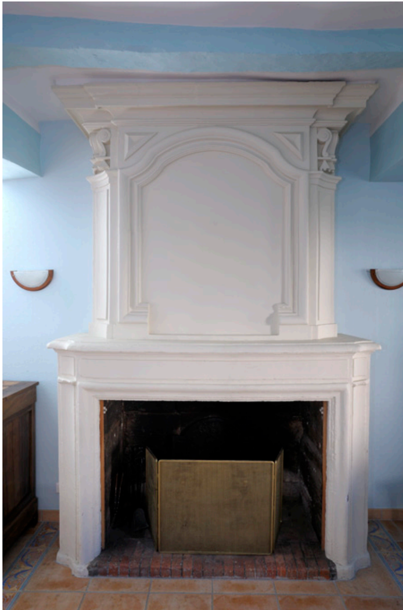
Logis est. Salle haute, cheminée du milieu du XVIIIe siècle.
