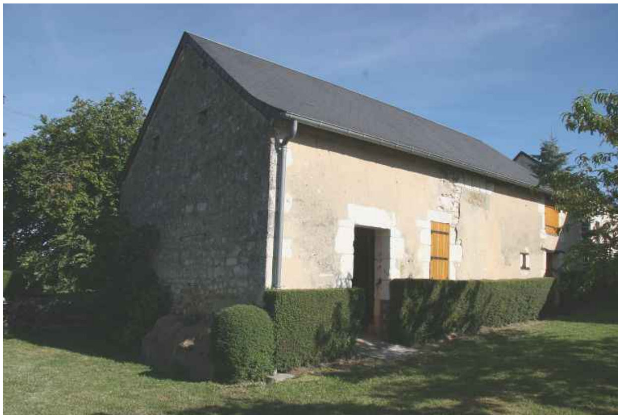
Maison 3 : façade antérieure.
