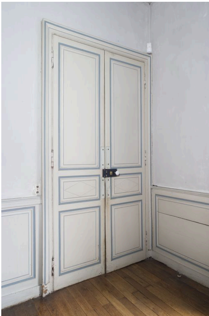
Rez-de-chaussée, salle ouest : porte donnant sur le vestibule.
