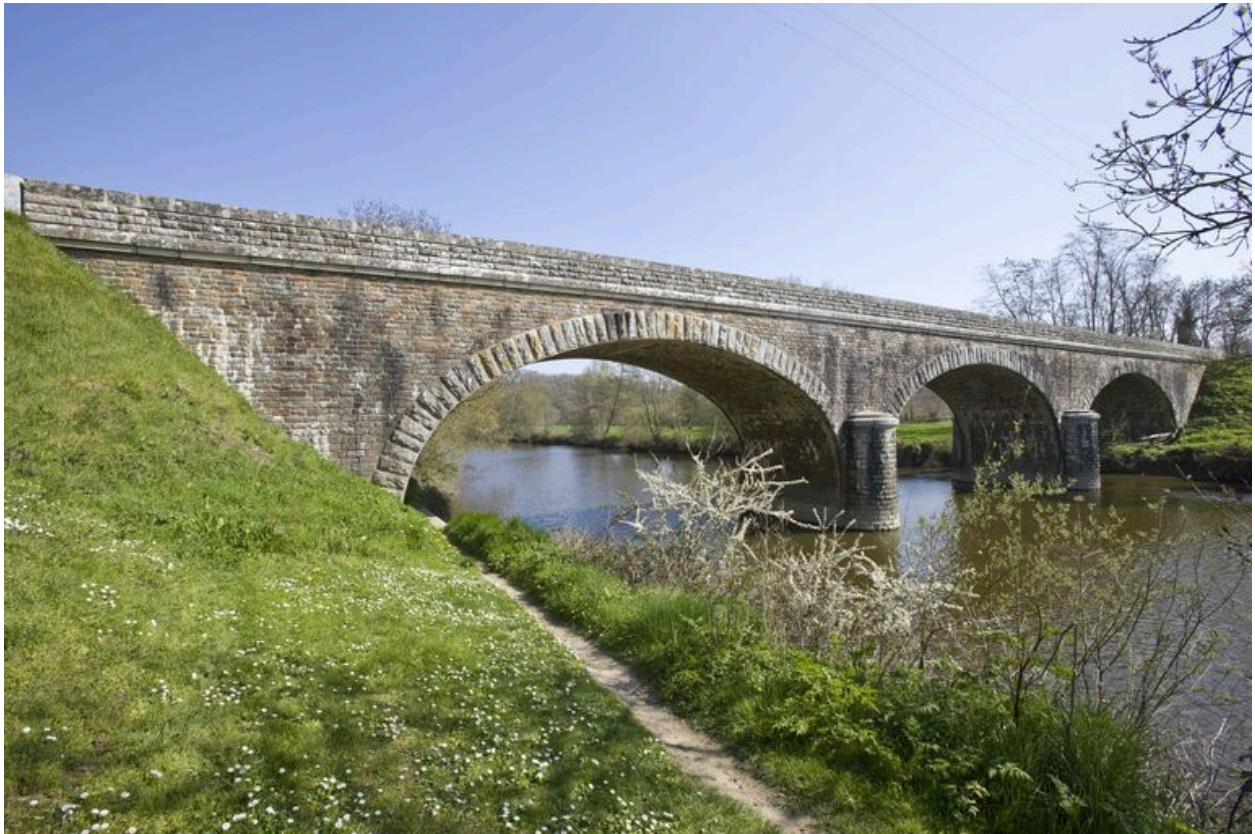
Le pont de la Haie-Fouassière.
