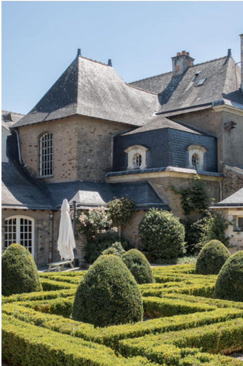
Vue de la façade nord et des bâtiments annexes.
