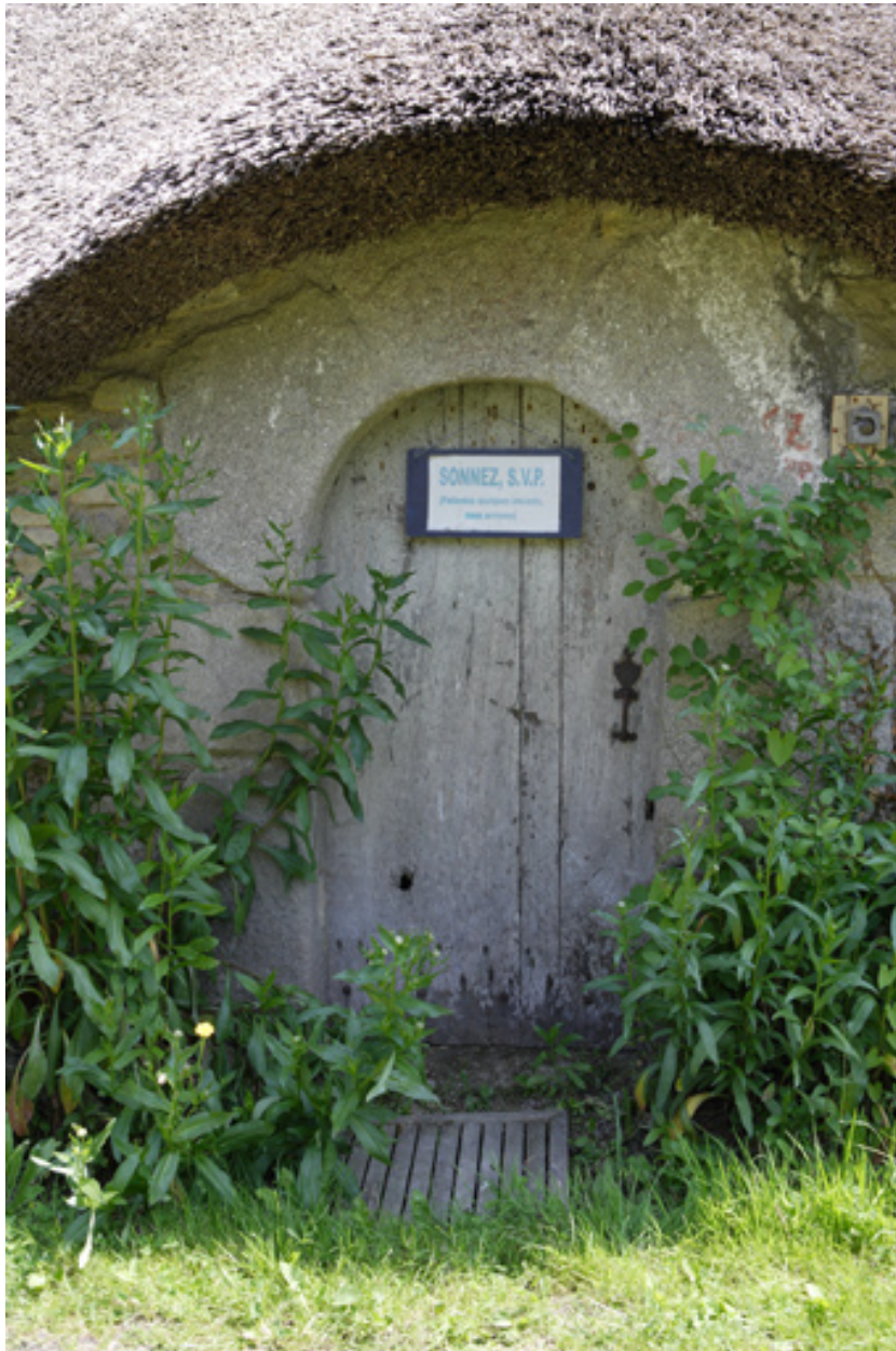
Détail de la porte de l'étable sud.
