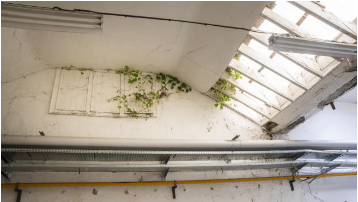
Fenêtres jumelées et shed de l'atelier de fabrication A.
