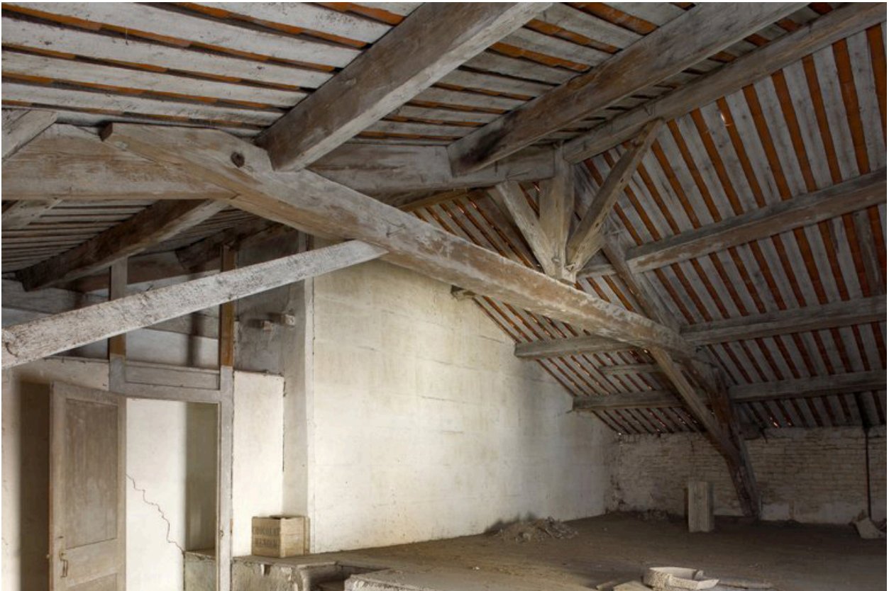
Vue de la charpente.
