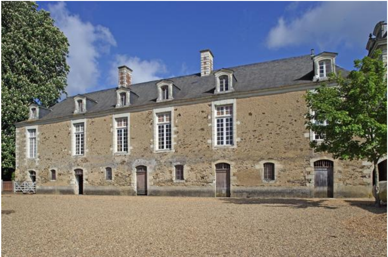
L'aile de communs sud, élévation postérieure.
