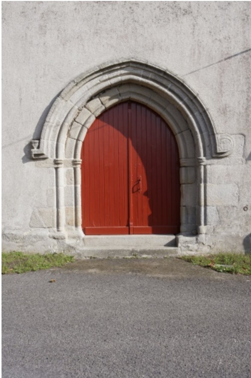
Détail du portail occidental.
