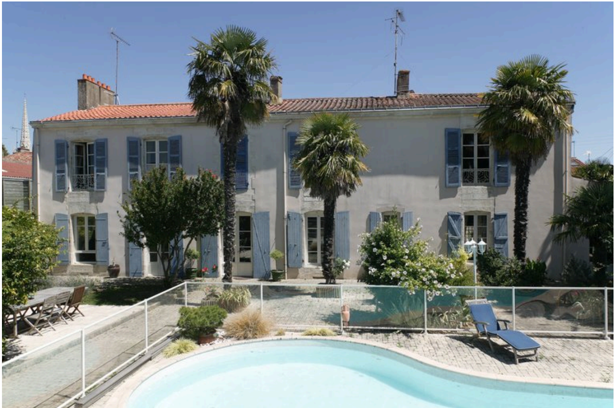
Façade postérieure sur jardin, donnant à l'ouest.
