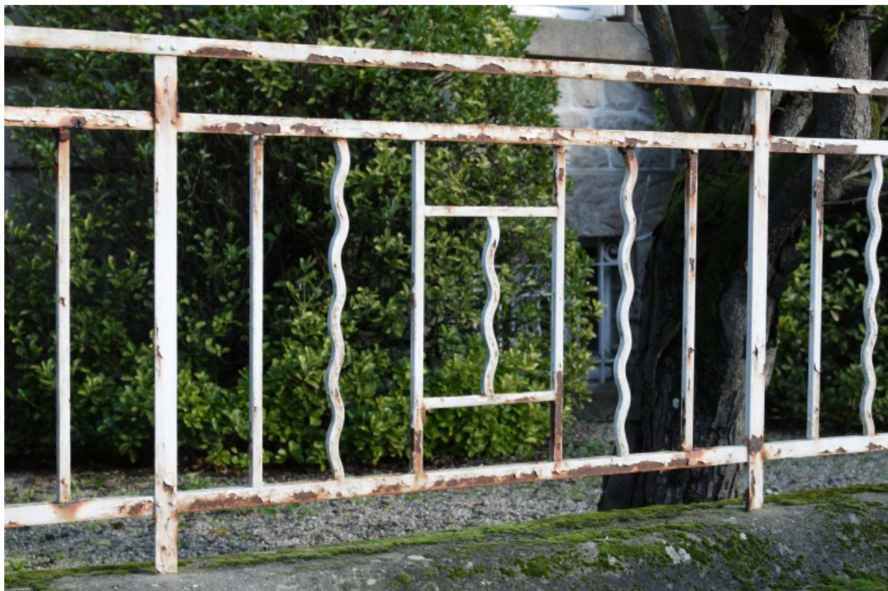
Clôture sur rue en fer forgé.
