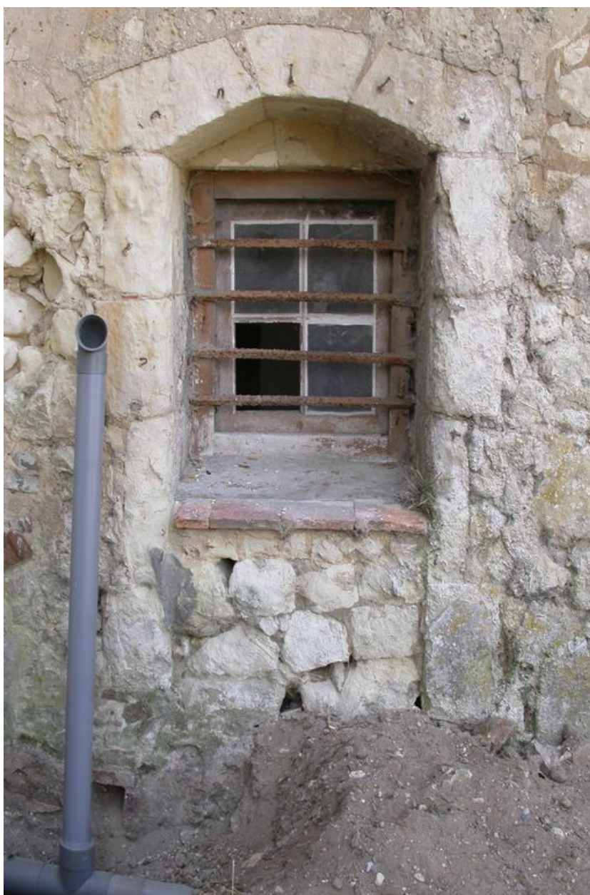
Aile en retour d'équerre du vieux bâtiment : petite baie.
