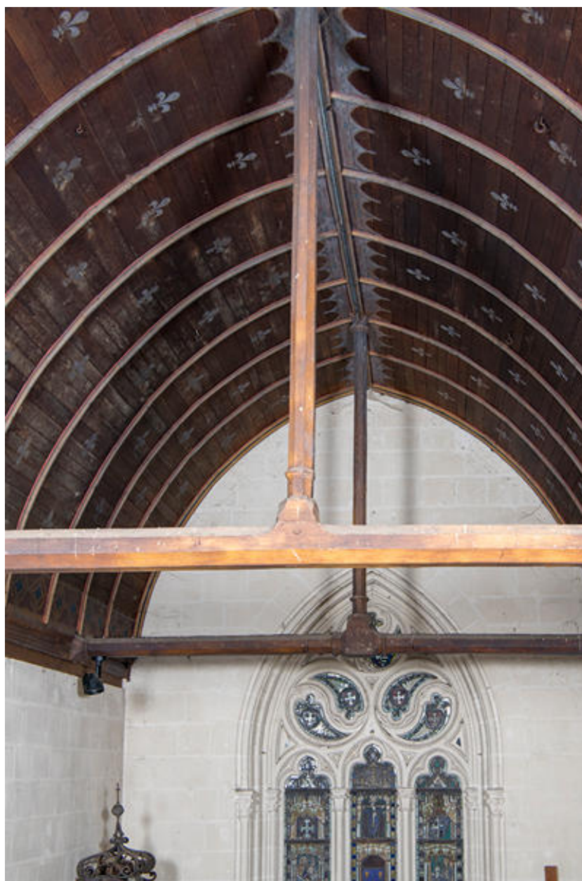
Choeur. Détail de la charpente lambrissée.
