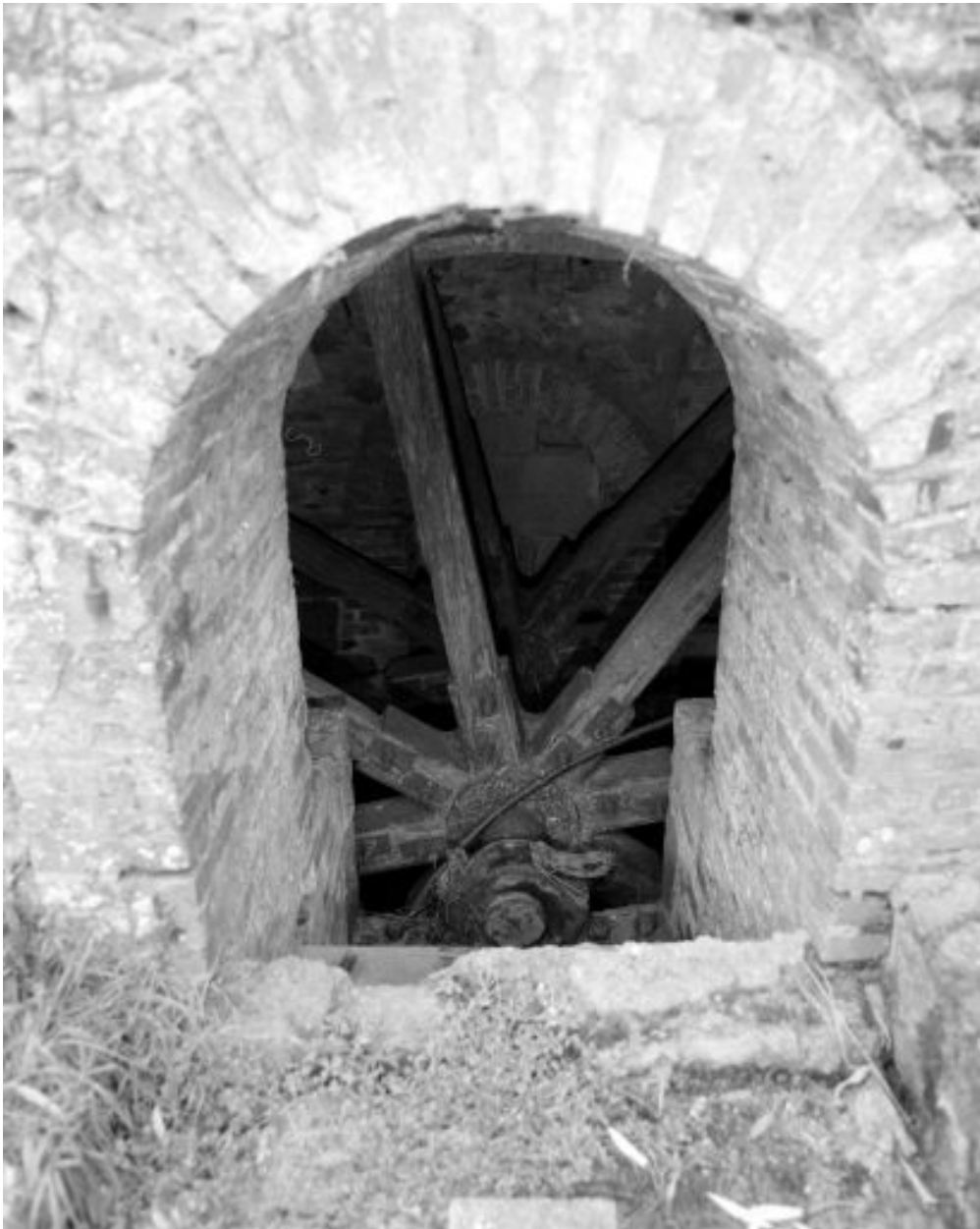
La roue vue à travers l'ouverture percée sur la façade nord-est.
