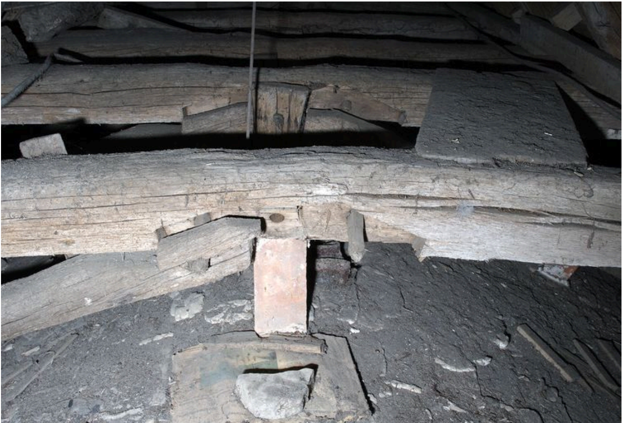
Charpente du chœur, 5e et 6e fermes, côté ouest : détail d'assemblage entre le faux entrait et les arbalétriers.
