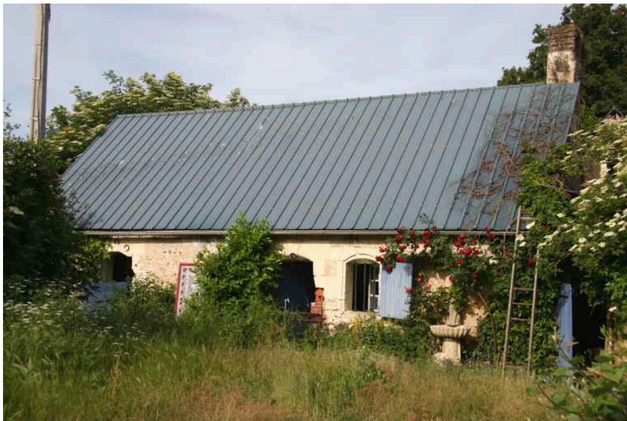
La maison : façade antérieure sur cour.
