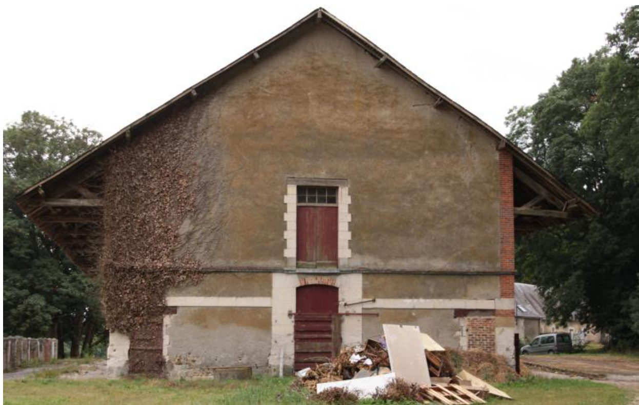
Vacherie : mur-pignon nord.
