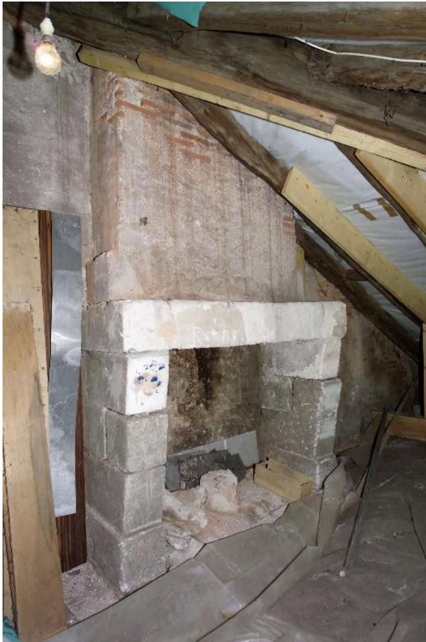
Le niveau de comble, la cheminée du corps de bâtiment sur le quai.
